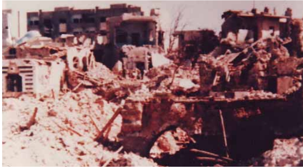
حماة بعد القصف
